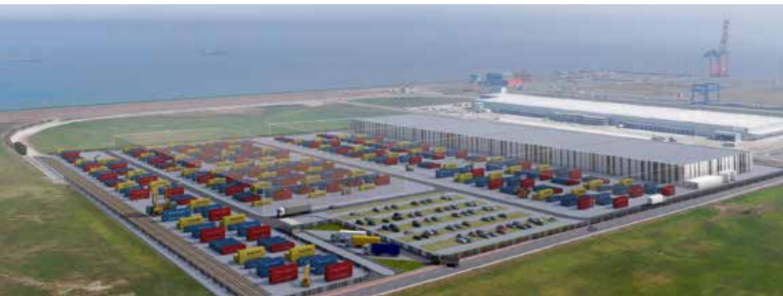
Großlager für Importe aus China: Auf 20 Hektar werden 40.000 Quadratmeter Hallenfläche und 110.000 Quadratmeter ungedeckte Lagerfläche gebaut
