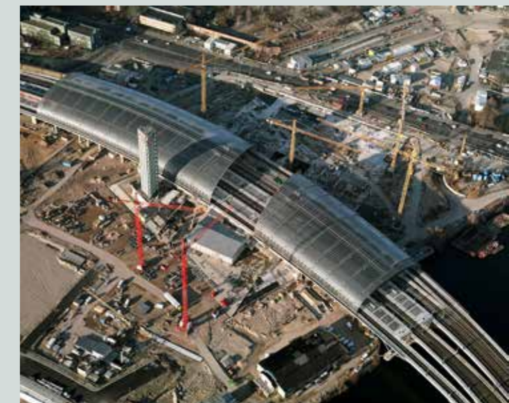
Bau des Berliner Hauptbahnhofs: Großprojekte dieser Dimension erleben häufig baubegleitende Dispute, die Gerichte oft nicht rasch genug klären können. Die Praxis sucht nach schnellen Möglichkeiten der Streitschlichtung
