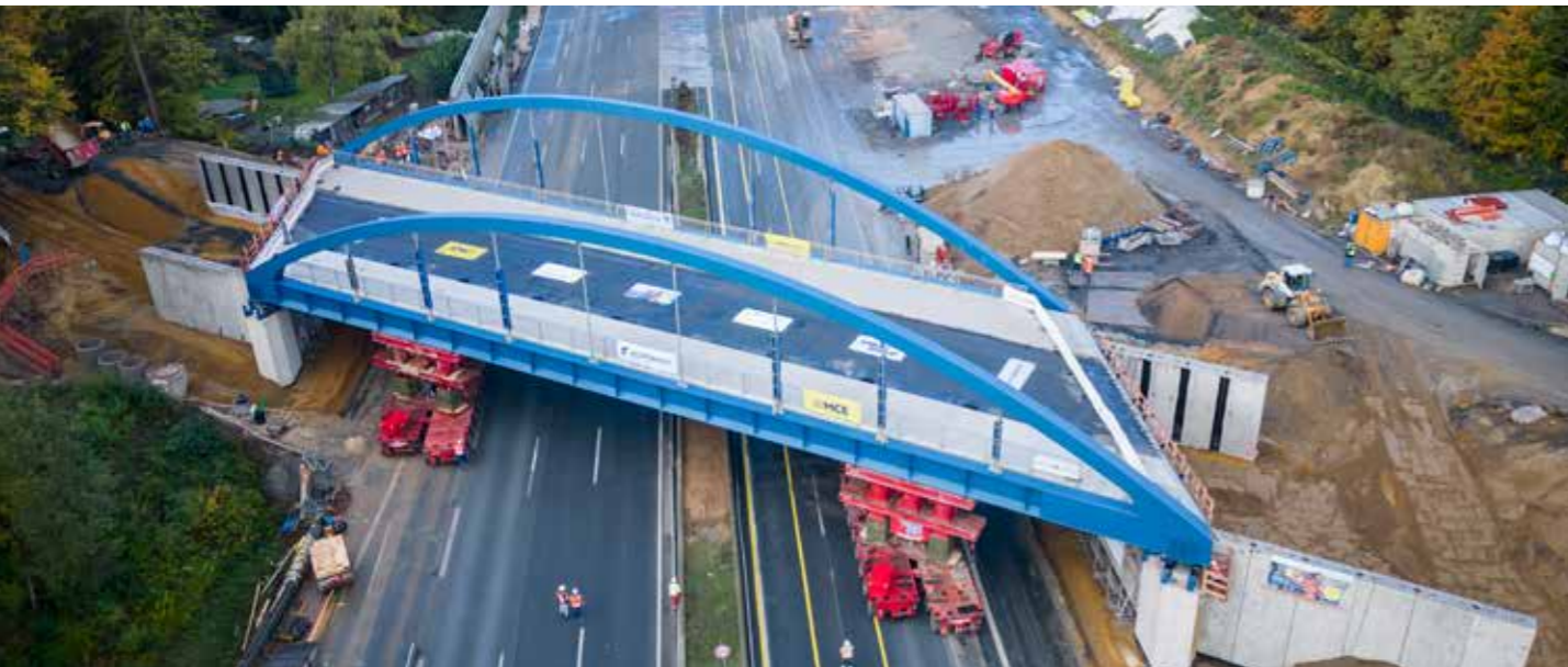
Das Brückenfeld ist auf den Widerlagern platziert. Was noch folgt, sind die beiderseitigen Anschlüsse und der Fahrbahnbelag
