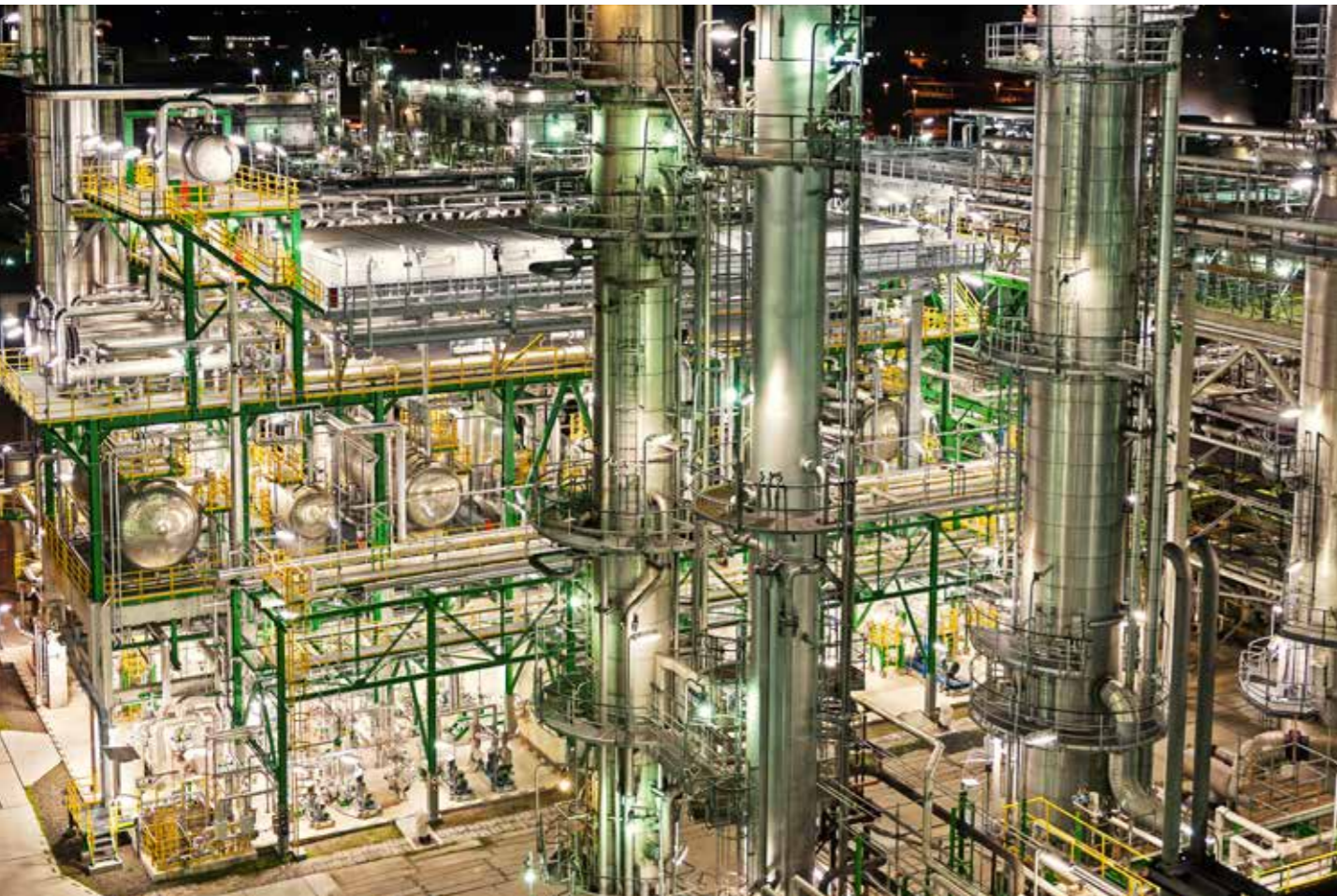
In der Raffinerie Schwedt wird aus besonderem Rohöl durch schonende Destillation Bitumen gewonnen
