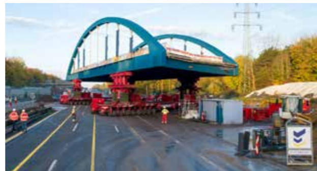
Die Express-Brücke auf dem Weg an ihren endgültigen Platz
