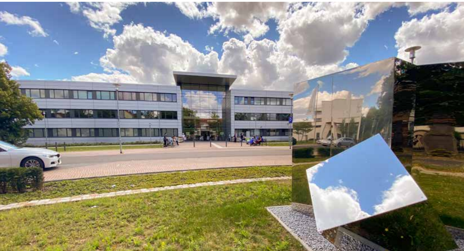
Das Hauptgebäude des Carl-Thiem-Klinikums in Cottbus
