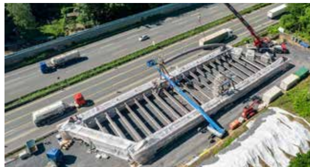
Montage des Brückenfeldes vor Ort
